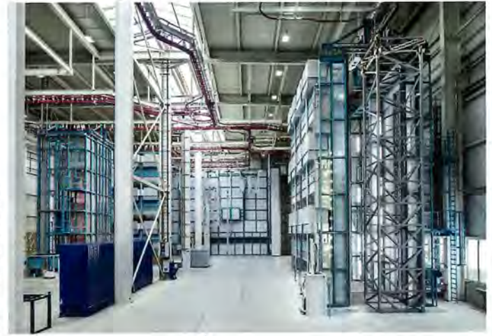
Turmstück vor der Einfahrt in die Grundlackkabine.
