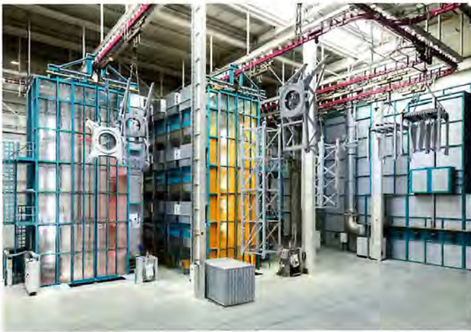
Zuführstrecken zu den Decklackkabinen.
