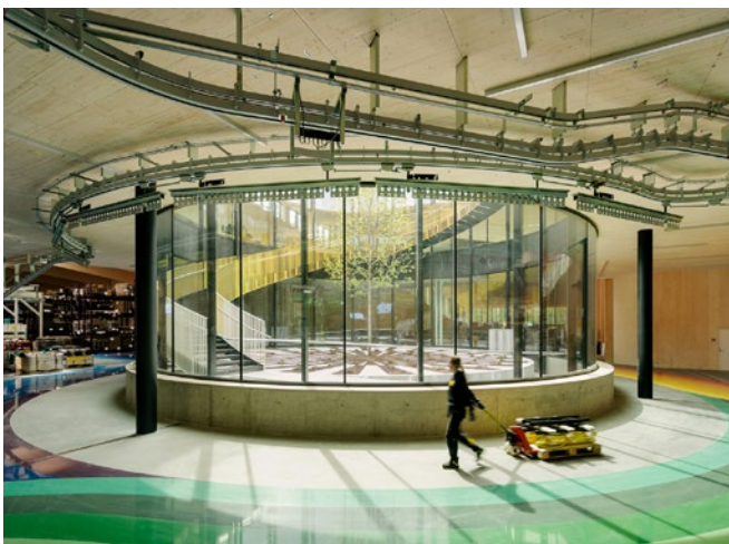
Das Zentrum: Von hier hat man alle Produktionsabteilungen im Blick, im „PLUS“ wurden insgesamt 800 Meter Förderschienen verbaut.
