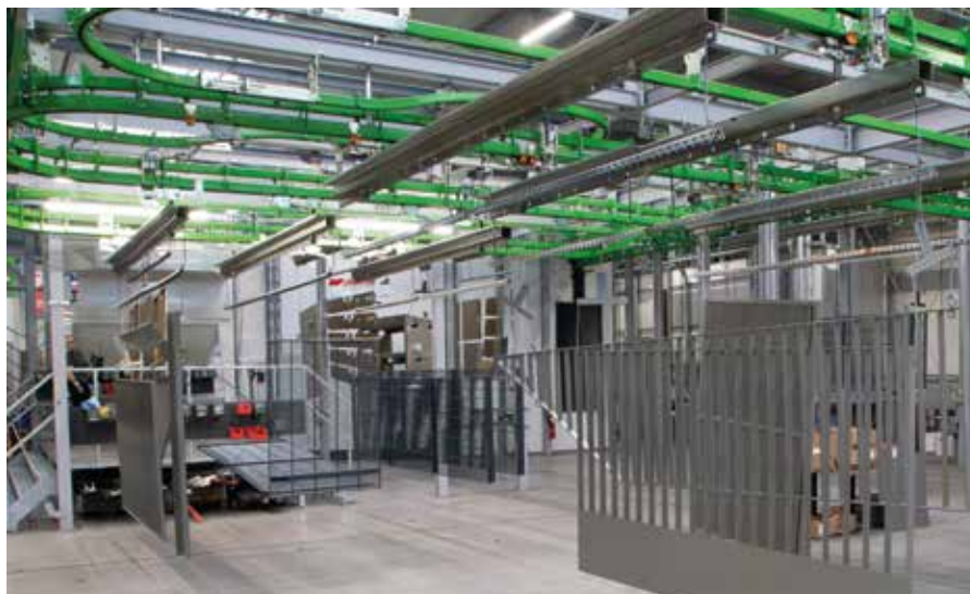
In der neuen Werkhalle ist viel Platz. Links im hinteren Bereich ist die Bühne für Maskierarbeiten zu sehen. Zum Lohnbeschichtungsportfolio gehören auch viele verzinkte Bauteile.
