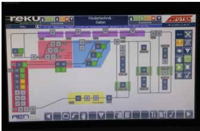
Die Lackieranlage wird per Touchbedienung gesteuert und bietet eine große, leicht verständliche Darstellung der Anlagenkomponenten.
