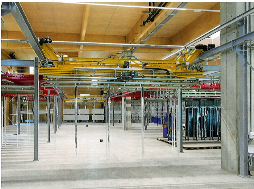
Blick in den Shuttle-Bereich mit den Puffern rechts und links.
